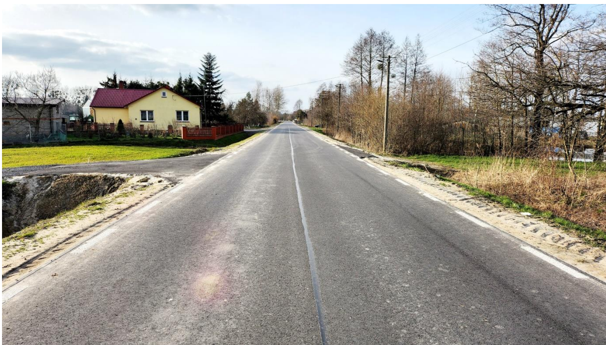
Przebudowana droga powiatowa w Raciborowicach Kolonii
