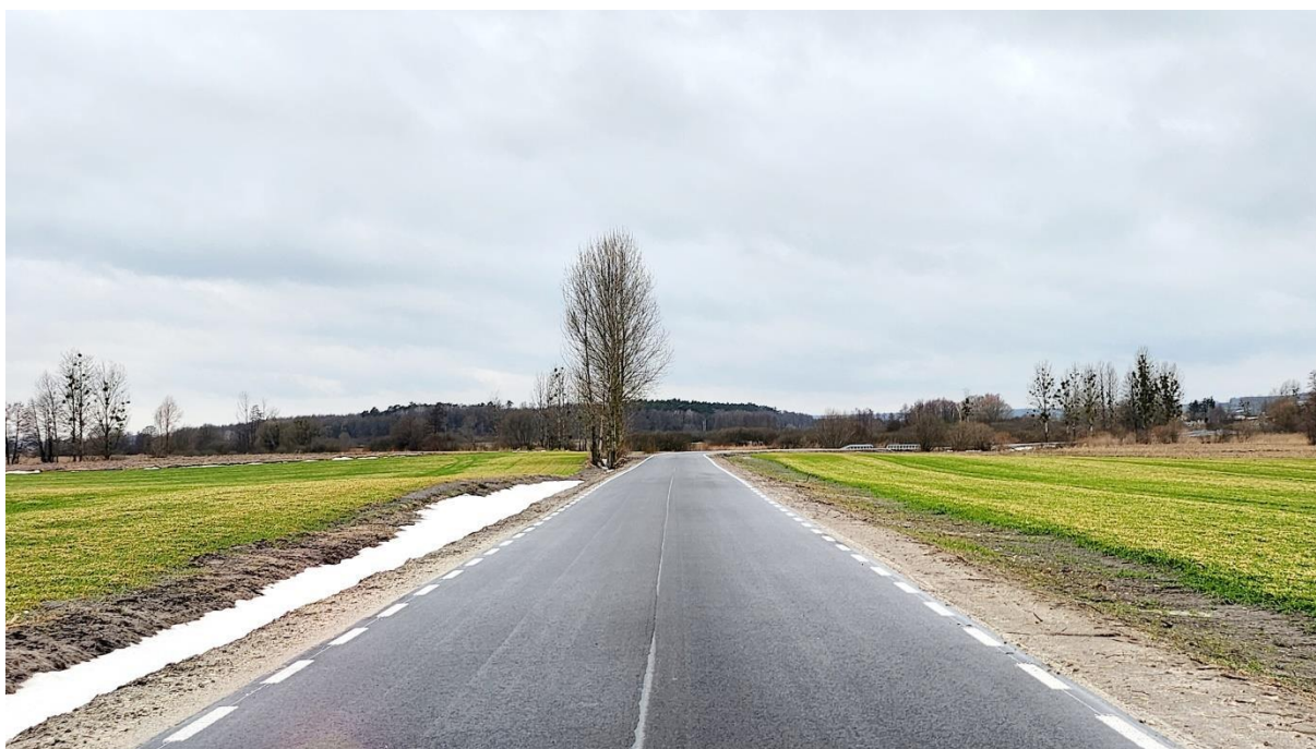
Przebudowana droga powiatowa Kurmanowie – Buśno
