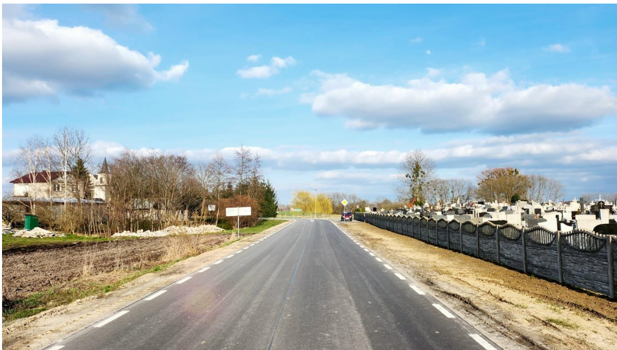
Przebudowana droga powiatowa Busieniec – Buśno
