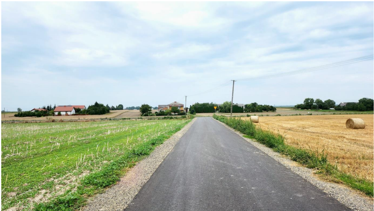
Zmodernizowana droga gminna w Raciborowicach, Strzelce - Kolonia – Raciborowice - Kolonia
