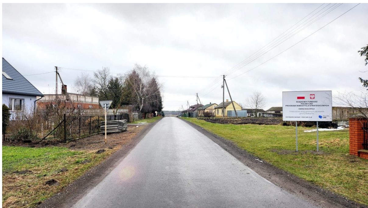
Zmodernizowana droga gminna Strzelce – Kicin
