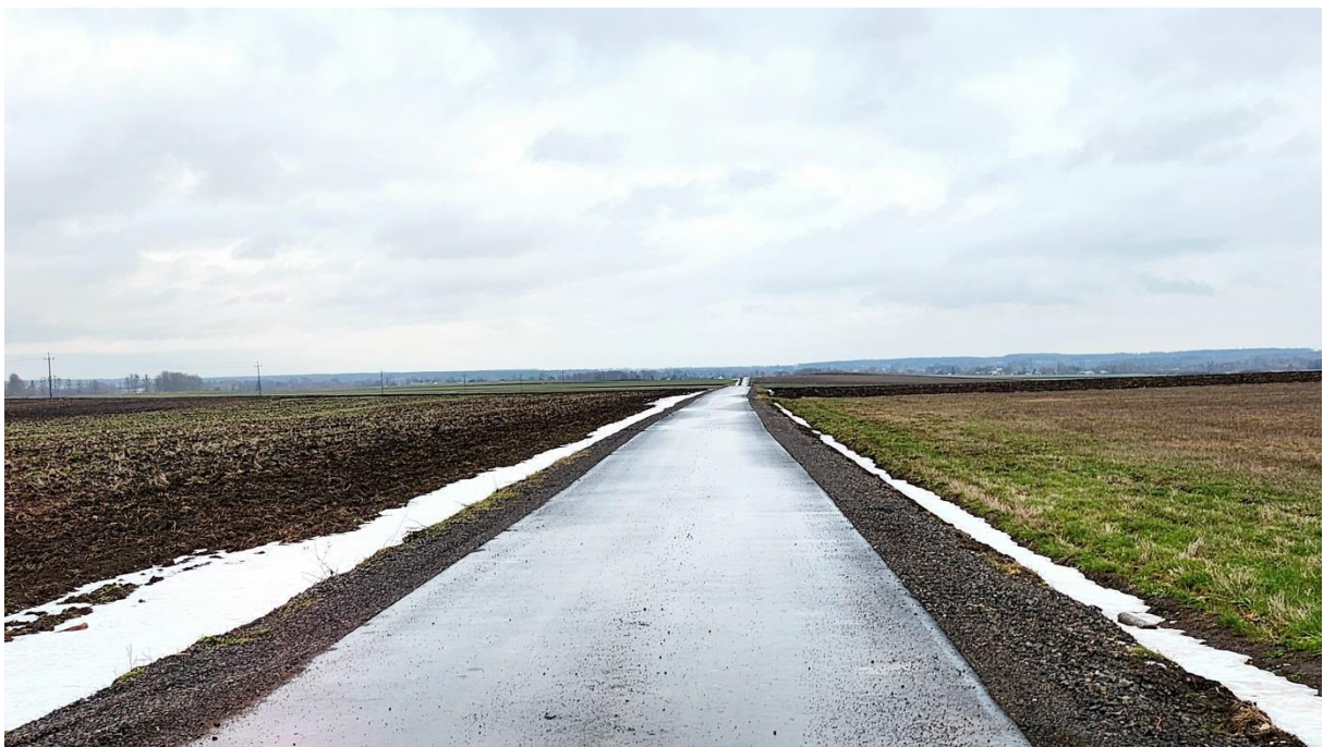
Zmodernizowana droga gminna w Buśno – Teresin
