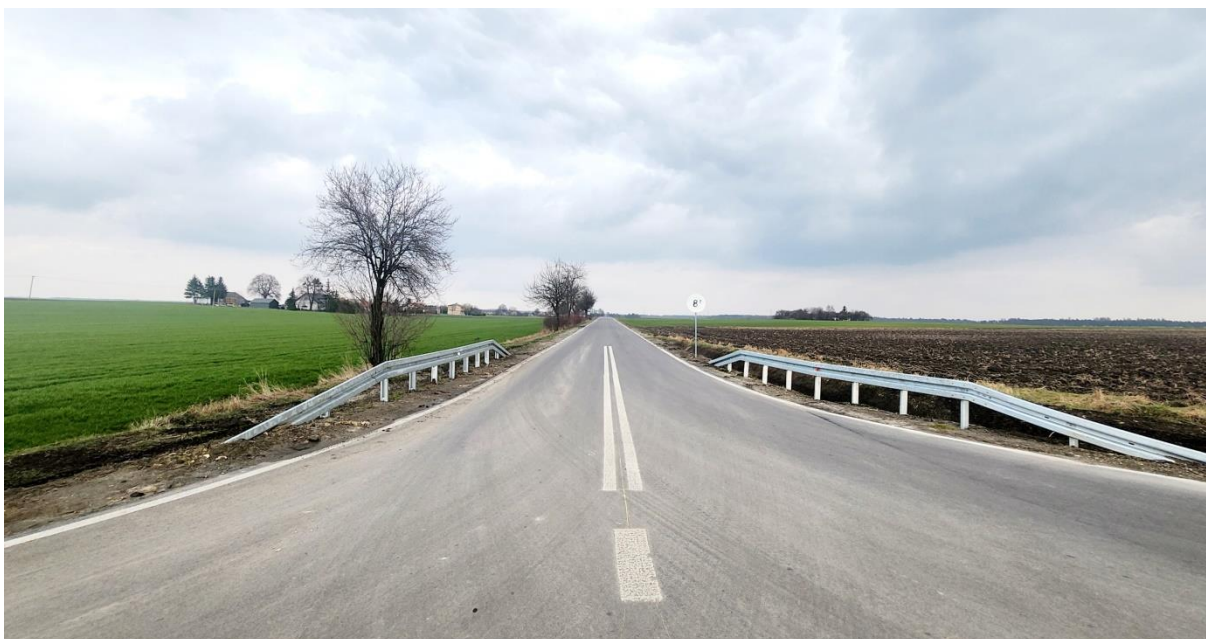
Przebudowana droga powiatowa Raciborowice – Strzelce - Kolonia – Horeszkowice
