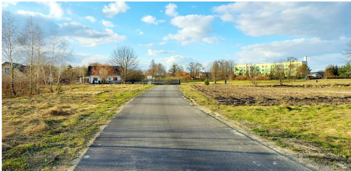
Wybudowana droga gminna w Kicinie.
